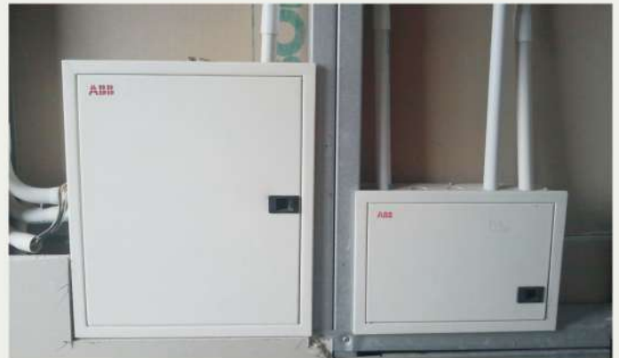
Conduit / MCB Box Fixing Arrangement
